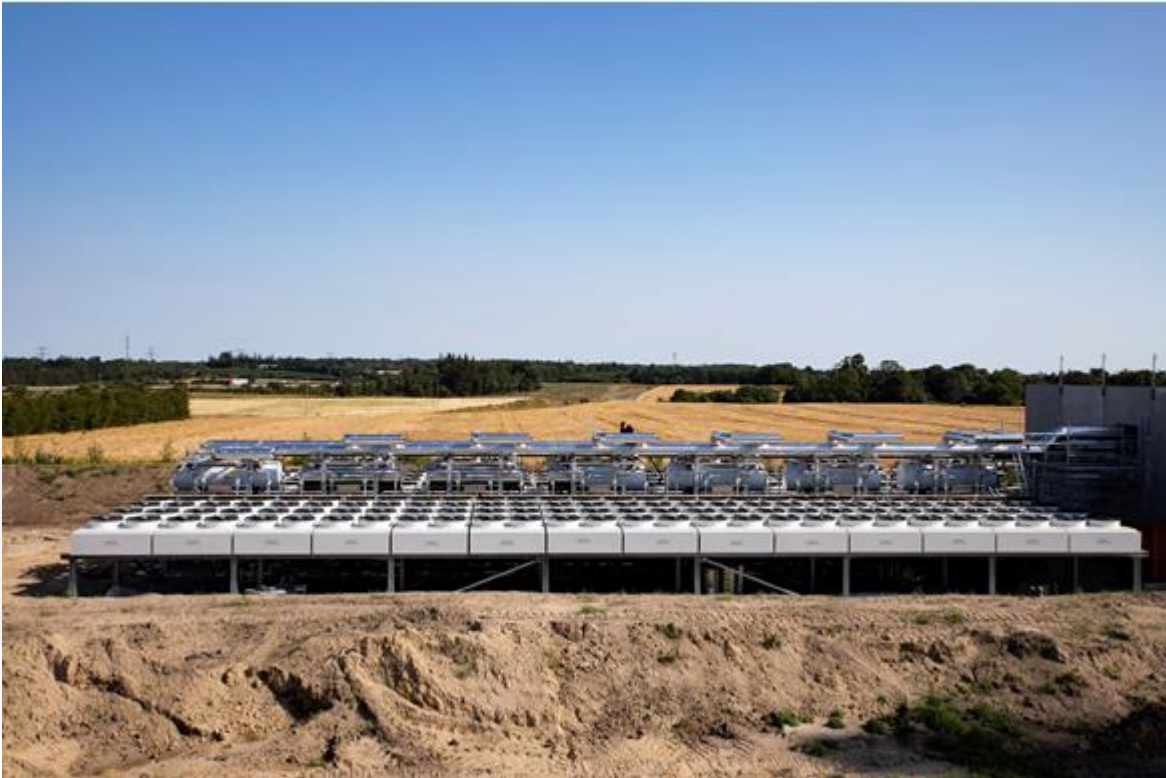
56 luftkølere opført hos Støring Kraftvarmeværk
