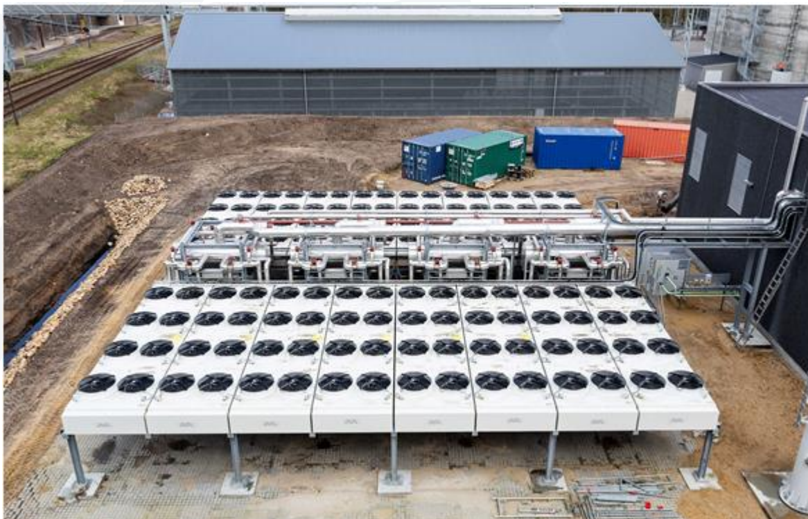
32 luftkølere opført hos Brande Varmeværk
